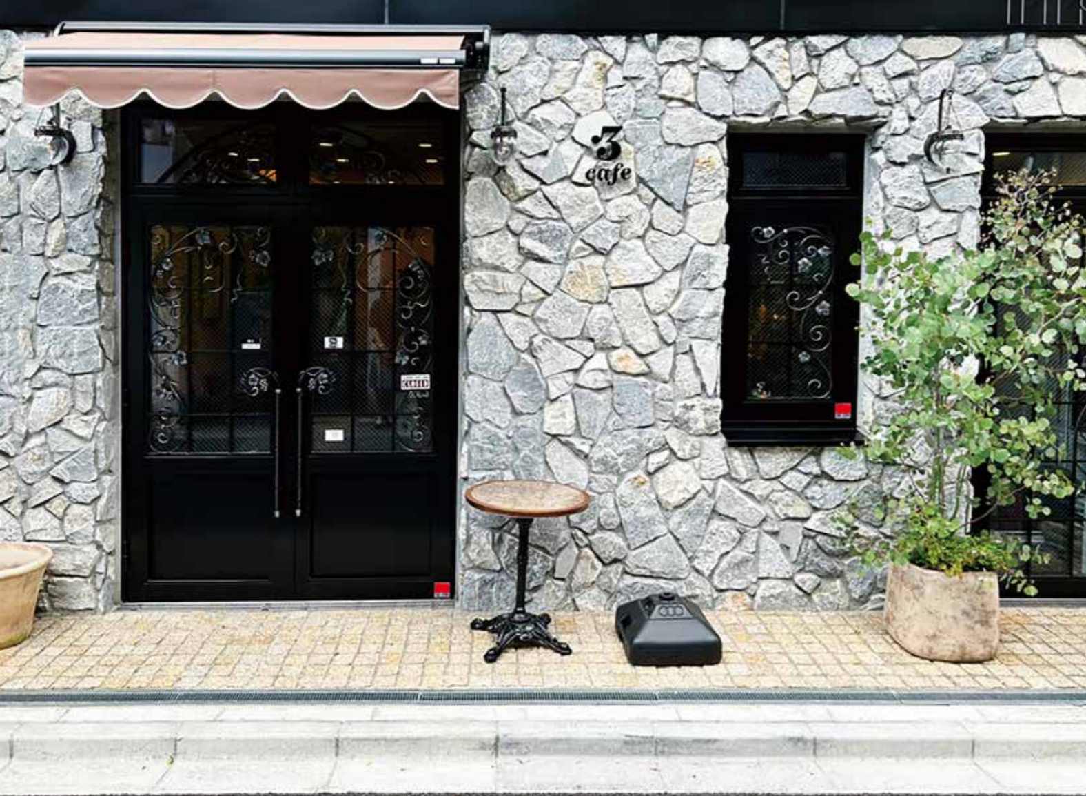
扉 W 847 × H 2111 枠 W 1760 × H 2686 枠 : ステンレス 焼き付け塗装 ブラック 建具 : ステンレス 焼き付け塗装 ブラック ガラス : 網入ガラス+Low-E ペア
