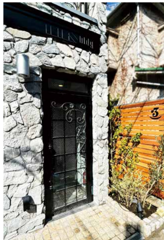
扉 W 847 × H 2111 枠 W 1760 × H 2686 枠 : ステンレス 焼き付け塗装 ブラック 建具 : ステンレス 焼き付け塗装 ブラック ガラス : 網入ガラス+Low-E ペア
